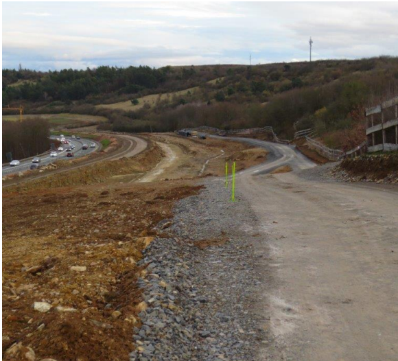
Kahlschlag entlang der Ausbaustrecke
